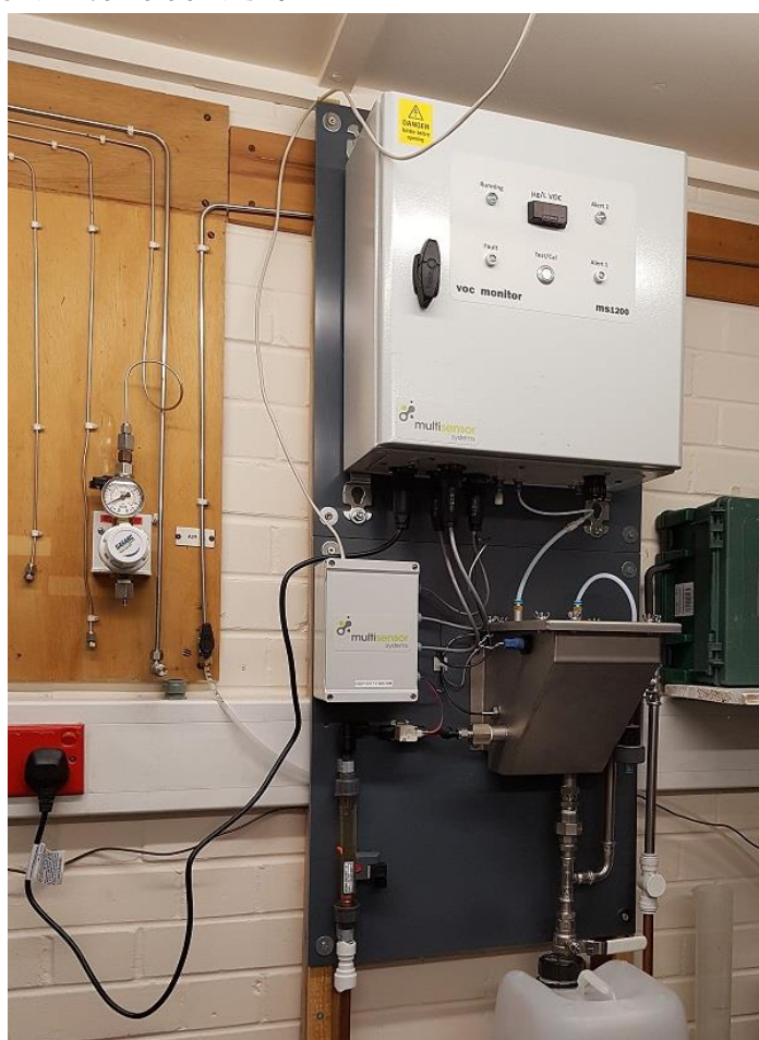
Figure 15 - 安装在建筑中的仪器的图片。该装置连接到记录数据的 PLC，并在发生事故时触发报警，从而关闭抽水泵。
