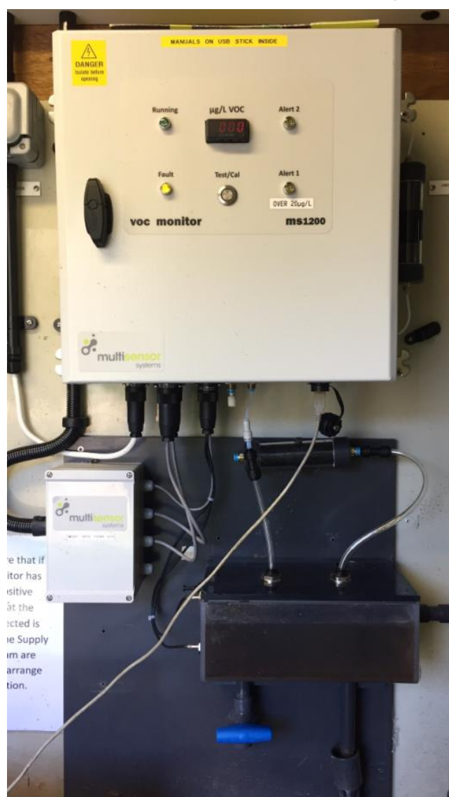
图16-安装在站房中的装置的图片。该装置可控制水闸门，在发生污染时，该闸门会关闭
