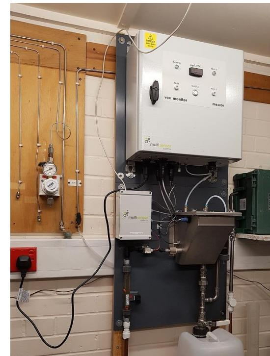
安装在外屋的仪器照片。该仪器连接到一个 plc，记录数据，并在发生事故时触发警报，关闭进水泵。
